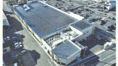
スーパーマーケット屋上への施工事例。負荷追従性能の高いWave Energy製の自家消費システムを採用した。
